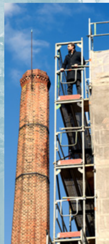
Das Sudhaus ist in der Ausführungsphase, sprich Umbauphase. Hier entstehen unten eine Gastronomie (180 Plätze mit regionalen Spezialitäten für jeden Geldbeutel) und oben Platz für gewerbetreibende Kreative.
