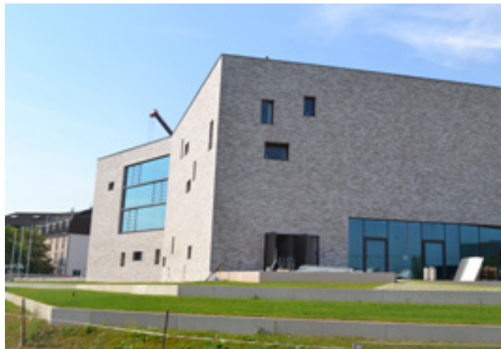
Nach gut dreijähriger Bauzeit wird die Stadthalle in Lohr am 1. Dezember eröffnet. Durch sie wird das Veranstaltungsangebot noch vielfältiger.
