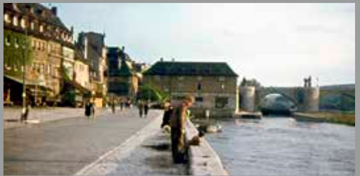
Unter dem Titel „Würzburg in Gegenüberstellungen“ zeigt die Geschichtswerkstatt im Verschönerungsverein im Oberen Foyer des Rathauses Würzburg noch bis 28. März die bauliche Entwicklung der Stadt in den letzten 120 Jahren anhand ausgewählter Gebäude, Plätze und Straßenzüge. Foto Alexander Kraus
